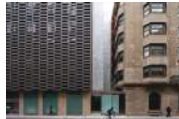
rehabilitación edificio hacienda navarra. pamplona. 2009
