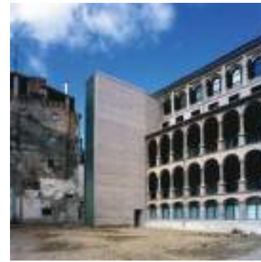
rehabilitación palacio de ezpeleta, pamplona. 2004
