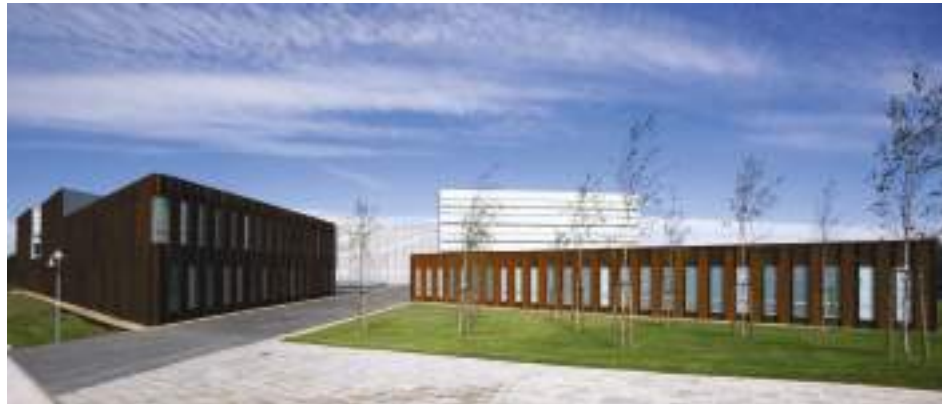
juntas generales de gipuzkoa, donostia. 2007
