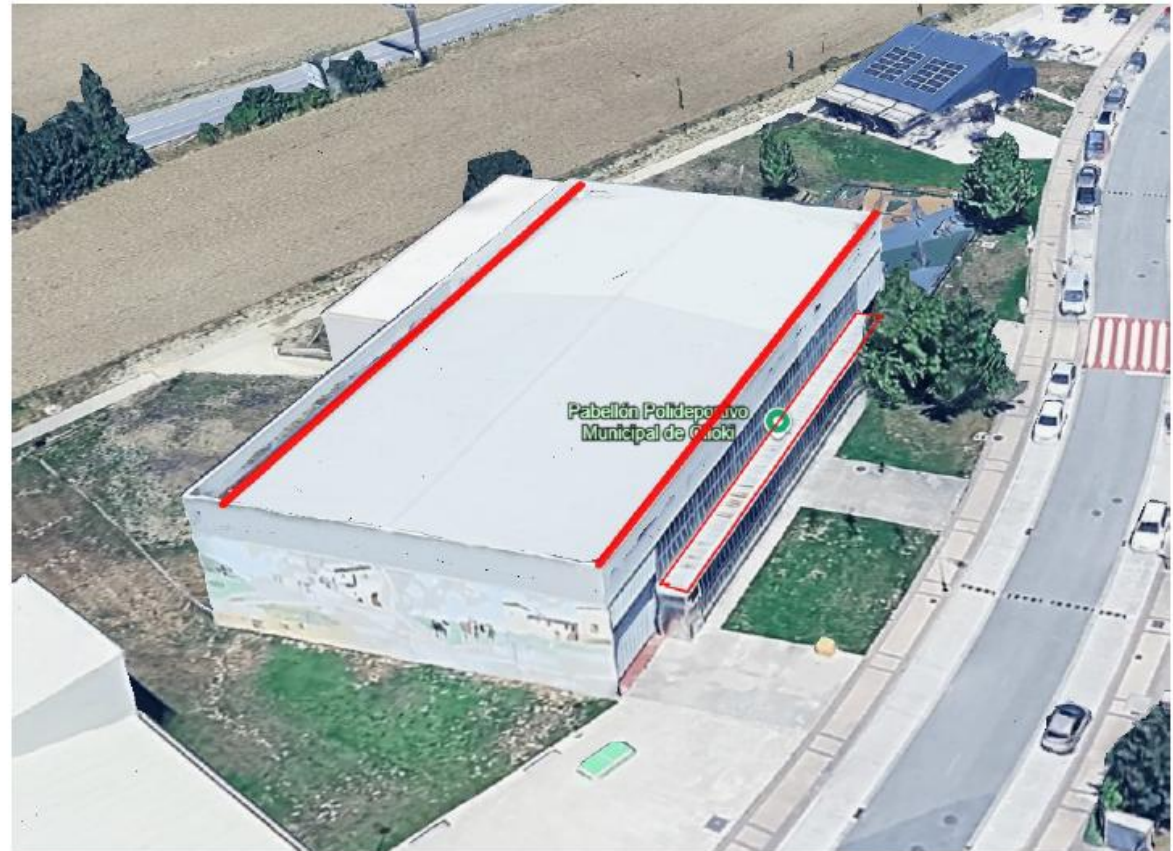
POLIDEPORTIVO DE OLLOKI; CANALONES Y CUBIERTA DE GRADERÍO
